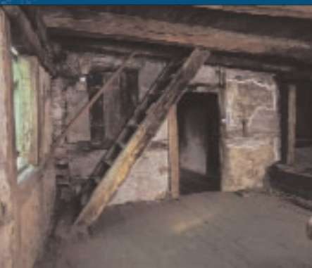
Die Diele im Obergeschoss, 2004 Der Wandschrank von 1475 wurde später von einer Treppe ins Dachgeschoss verdeckt. Der Wandputz mit den Malschichten aus der Erbauungszeit wurde bereits von einem Restaurator gesichert.
