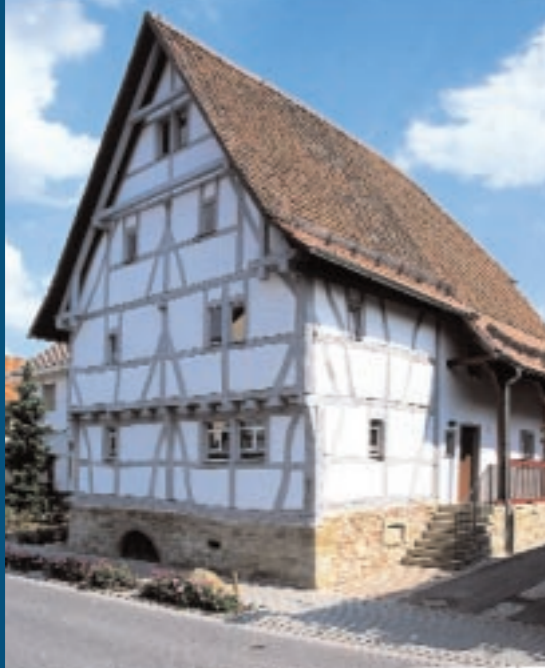
Firstständerhaus von Norden, 2008 Das Firstständerhaus nach der Sanierung. Wieder hergestellt wurde der Schwebgiebel der Erbauungszeit. Wegen der Straße musste der Kellerabgang von 1781 zu einem Fenster vermauert werden.
