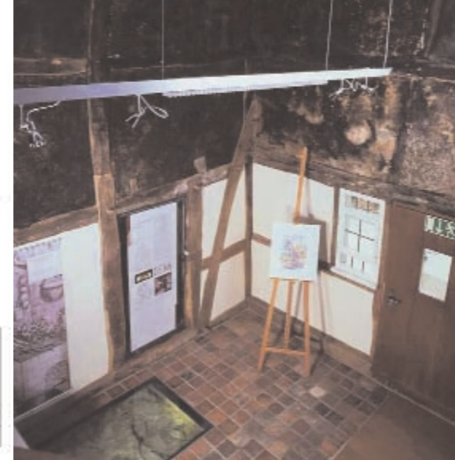
Blick in die Küche, 2008 Links unten im Bild sind die Fundamente der Herdstelle unter Glas konserviert. Der Rauch hat die Wände geschwärzt.
