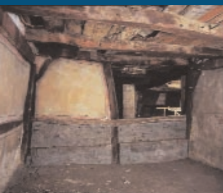
Kammer im Obergeschoss, 2004 Die Kammer vor der Sanie- rung. Ein Fachwerkkfeld zur zweigeschossigen Küche fehlt und gibt den Blick frei auf das ursprüngliche Rauchabzugsloch und den neuzeitlichen Kamin. Der Fußboden besteht aus einem Kalkestrich.
